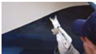
Påføring av bunnstoff
