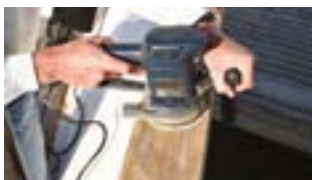
Maling og lakkering av treverk
