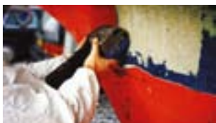
Fjerning av gelcoat med gelcoathøvel
