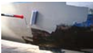
Påfør Underwater Primer på de forbehandlede overflatene
