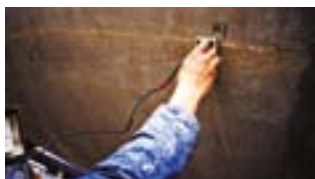
Måling av fuktighet
