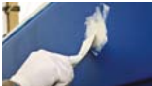
Påføring av sparkel med spatel
